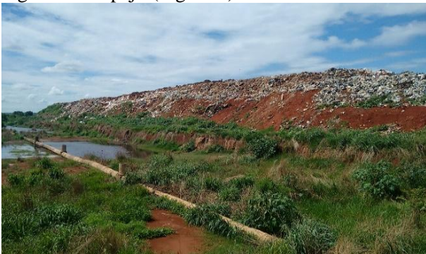
Figura 1 – Vista Lateral do Aterro de Resíduos Sólidos Urbanos de Rio Verde – GO
