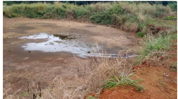
Figura 2 Lançamento irregular de Chorume diretamente no solo.
